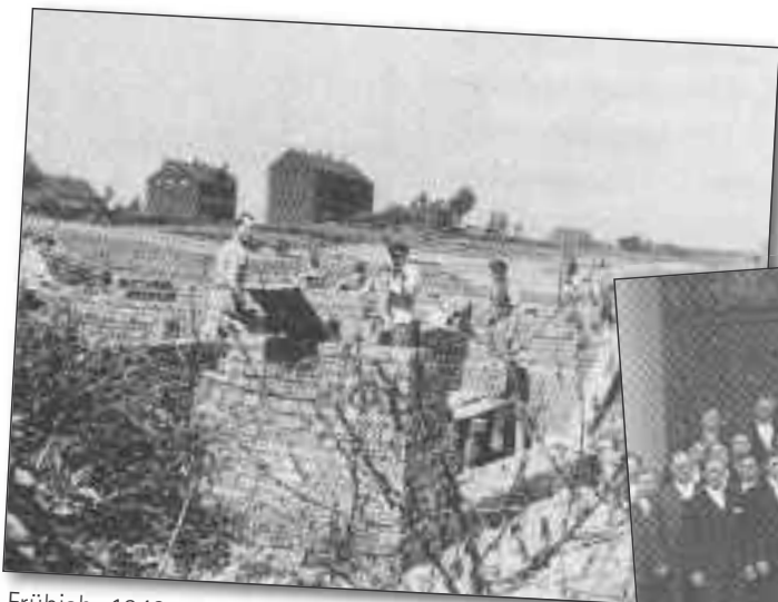
Frühjahr 1949 – zweiter Bauabschnitt der Siedlung, im Hintergrund der Tabor
